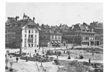
Bern, Bundesplatz Bauarbeiten Fotografie, Sommer 1900 Burgerbibliothek Bern
