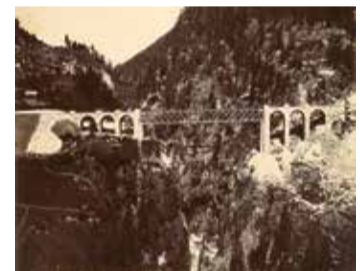
Eisenbahnviadukt, Gotthardstrecke bei Wassen Fotografie, Albuminabzug, um 1880
