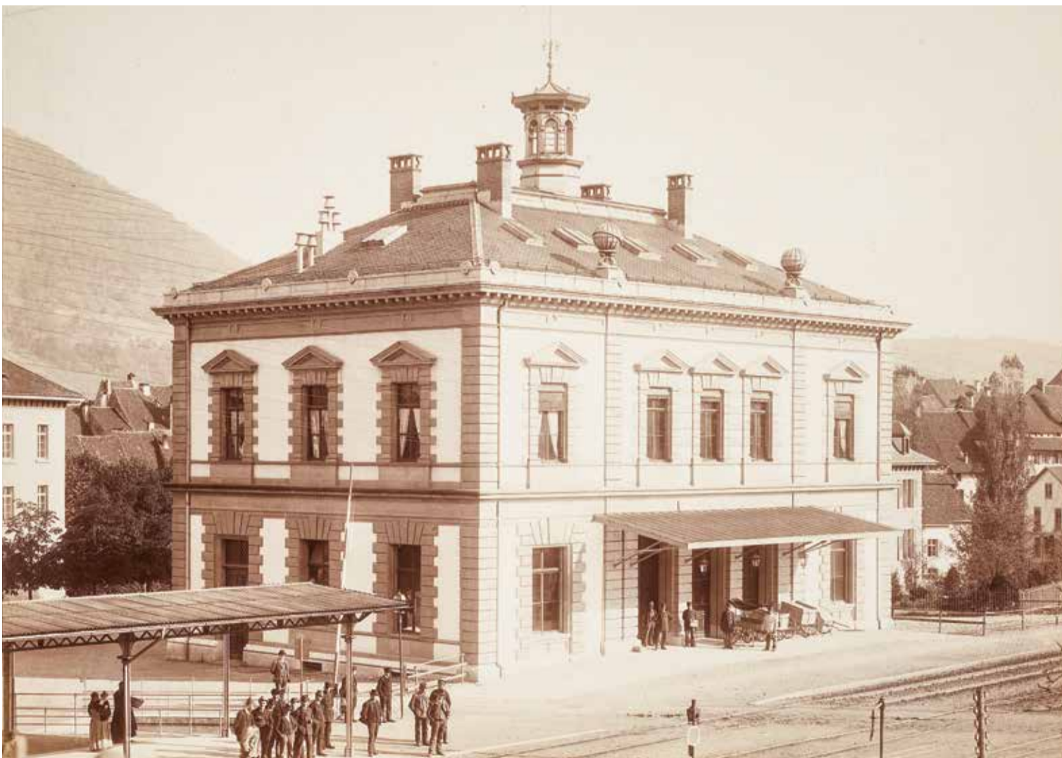
Im Rückblick bezeichnet Hans Wilhelm Auer das Postgebäude in Liestal (1892) als sein bestes Projekt: Hauptfassade und Fassade an den Gleisen. Vgl. S. 73f. Sammlung Museum für Kommunikation, Bern
